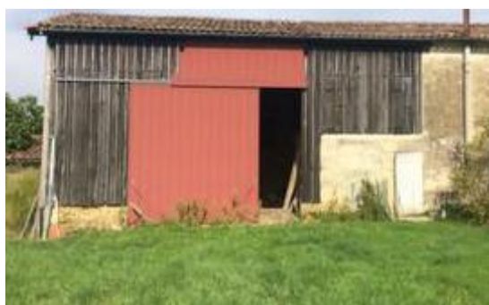
Avant et après les travaux, côté sud. AGNÈS CLOTIS
